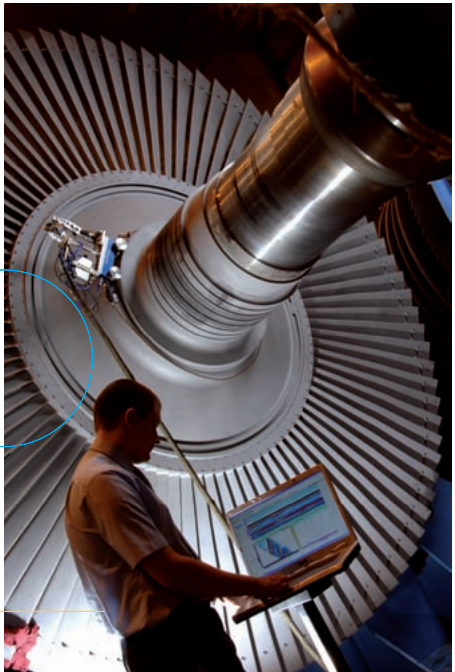
Ein Inspektionsroboter von ALSTOM Inspection Robotics inspiziert einen Dampfturbinenmotor auf Risse
